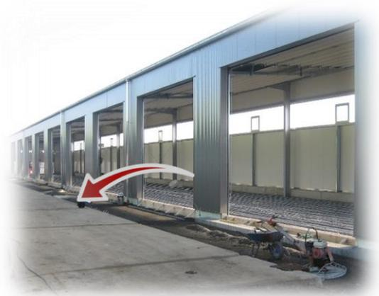
Hallentore über die gesamte Front des Gebäudes lassen beim Öffnen schnell die warme Raumluft entweichen.
