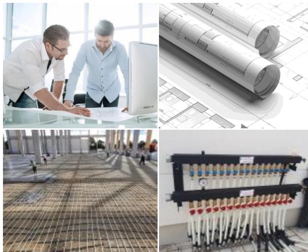
Bei der LoWaTec Industrieflächenheizung/-kühlung **System Q4** können Hallenflächen bis zu 6.000 m<sup>2</sup> an einen einzigen Verteiler angeschlossen werden. Dies unterscheidet LoWaTec Q4 von der klassischen Industrieflächenheizung, wo Flächen bis zu 1.200 m<sup>2</sup> an einen Verteiler angeschlossen werden können. Entscheidende Vorteile sind:
